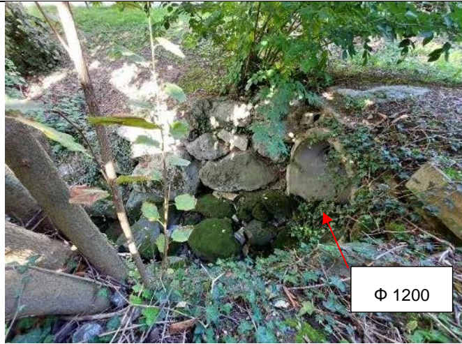
Exutoire du Nantet aval traversée urbaine
