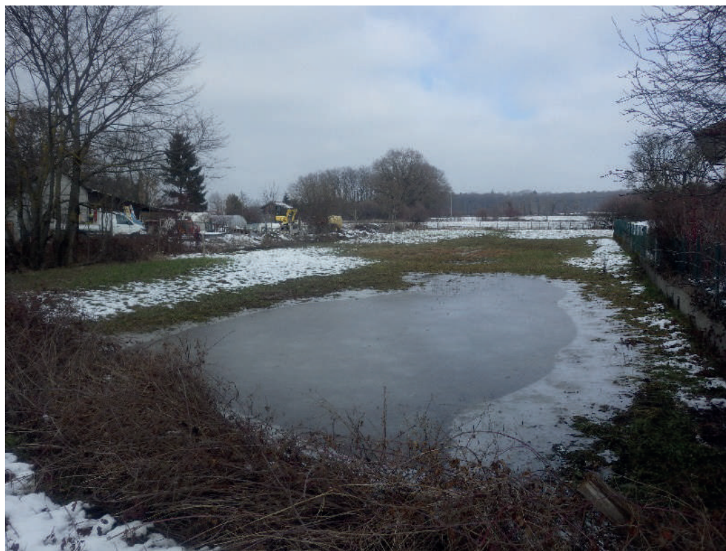
Photo 4 - Engorgement d'eau constaté en février 2019 (crédit photo : Acer Campestre)
