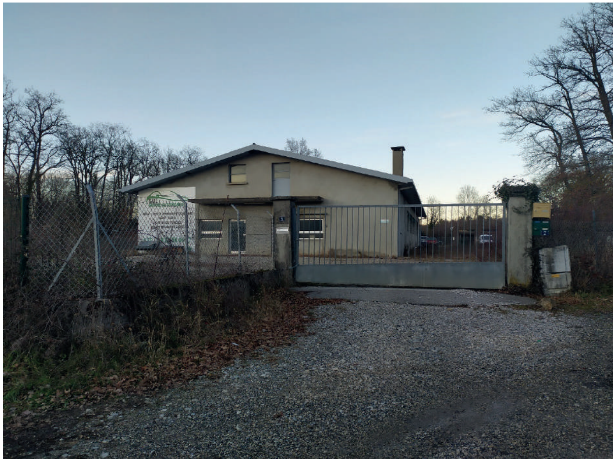
Photo 11 : Garage désaffecté au sein du périmètre d'étude
