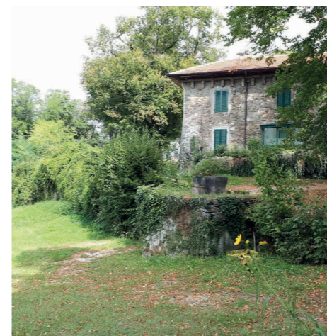
Avant les travaux de débroussaillage
