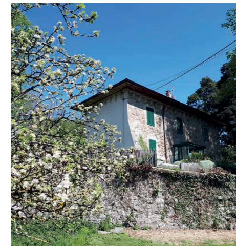
Après le débroussaillage
